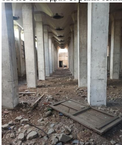
Фото 27. г. Красноуфимск, элеватор
